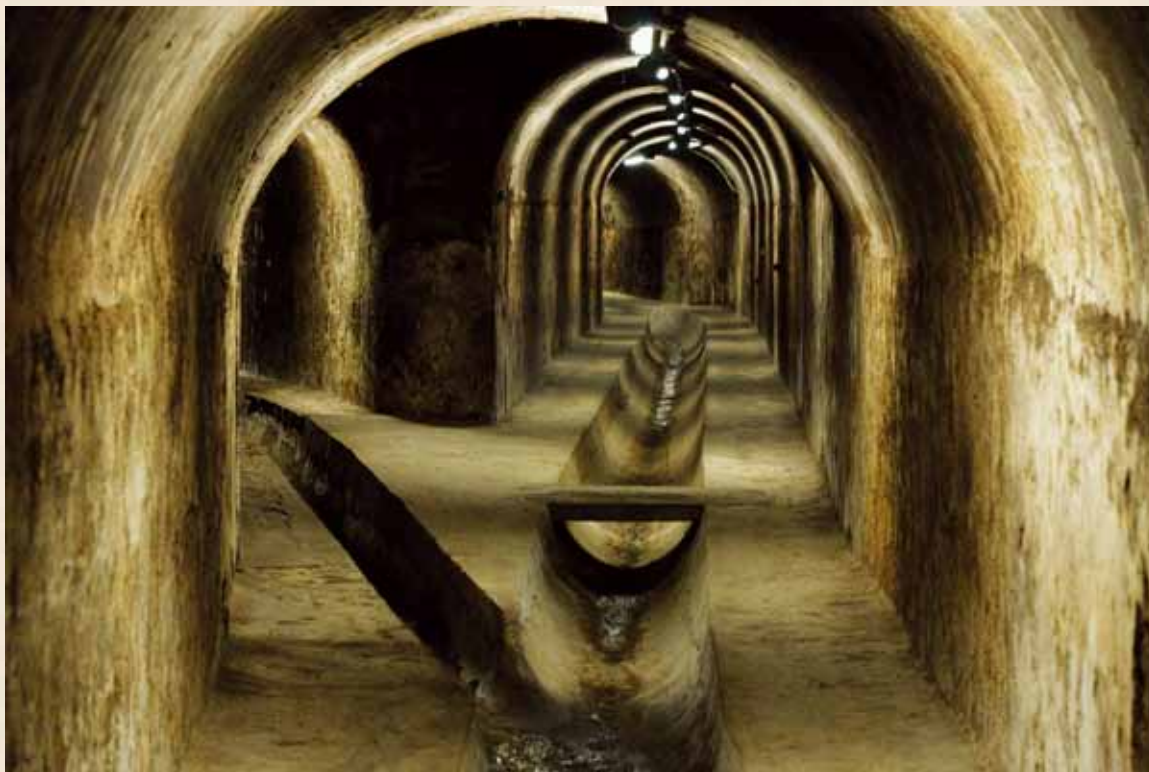
Cloacas de Barcelona. Jorge Zorrilla © バルセロナの下水道
