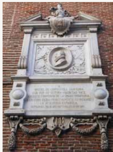
ラス・トリニタリアス修道院の外壁に刻まれるセルバンテスがここに眠ることを公示する石版。
